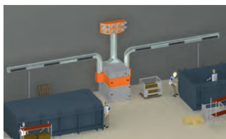
Производительность вытяжной системы: 9.000 м 3 /ч
